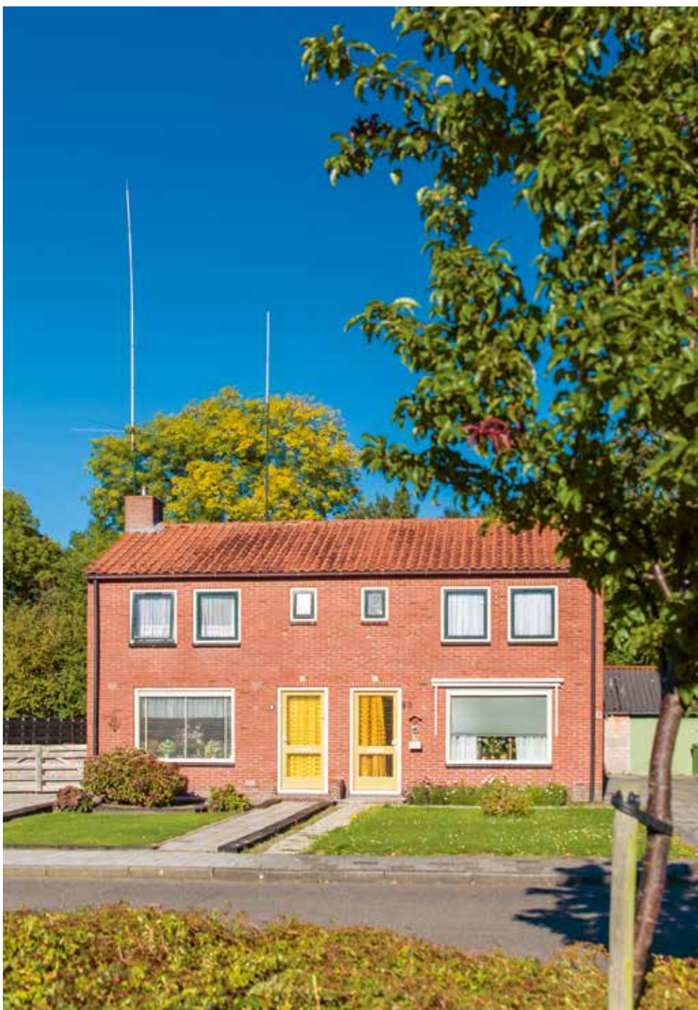
Woningen in de H.J. Siemonsstraat die de bewoners van sloop willen redden
