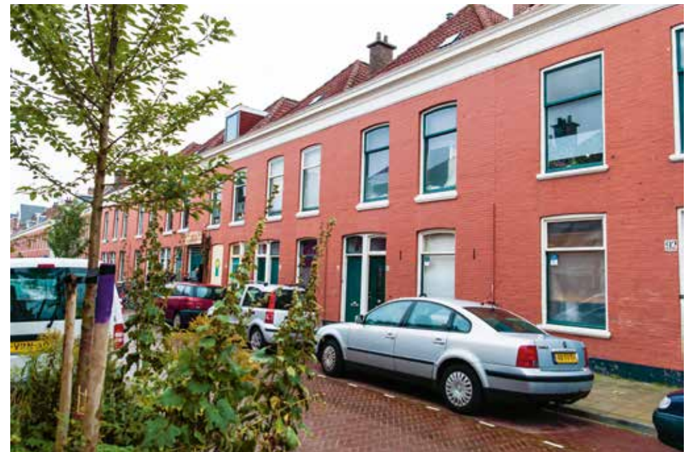
Dit blok wil de woningbouwcorporatie slopen
